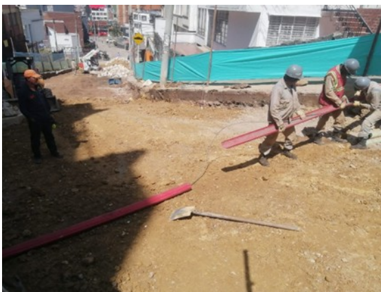
Reparaductos de Fibra óptica
