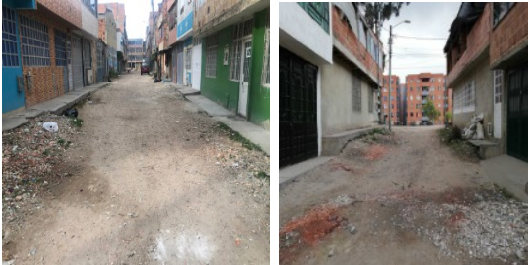
Figura 1 – Carrera 96 entre Calle 38 Sur y Calle 40 Sur
