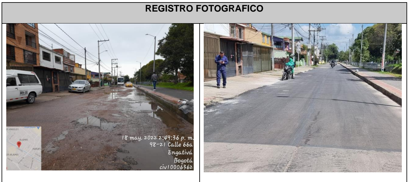
Ilustración 3. Registro fotográfico CIV 10006362 – PK 164833
