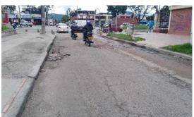
Con base en la verificación y la visita técnica de inspección visual realizadas, se pudo establecer que el tramo correspondiente a la vía de su solicitud se encuentra con superficie en pavimento Flexible, es de uso vehicular y requiere ser intervenida mediante actividades de cambio de carpeta.
