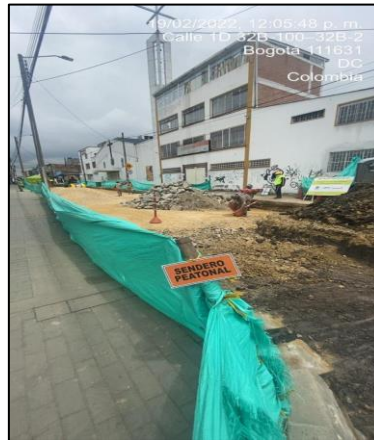
"Carrera 32B entre calle 1D y calle 1F costado oriente"
